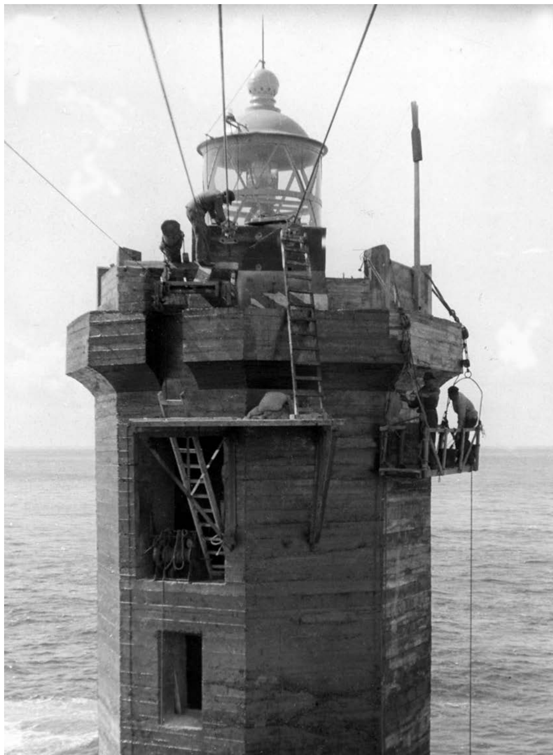
Construction du phare de Nividic, île d'Ouessant (Finistère) en 1934. La lanterne est déjà posée avant les finitions du fût, cliché photothèque CETMEF.
